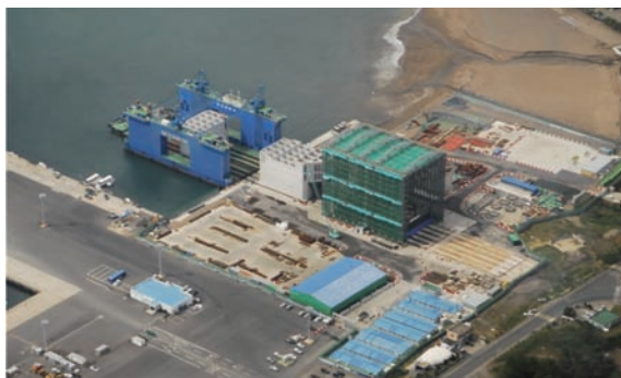
사진 4. 화순항 케이슨 제작장 전경
