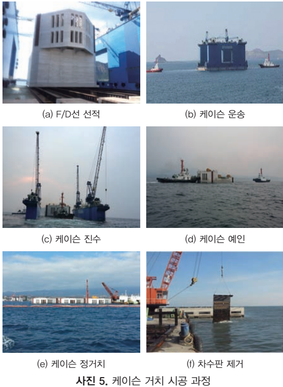
사진 5. 케이스 거치 시공 과정
