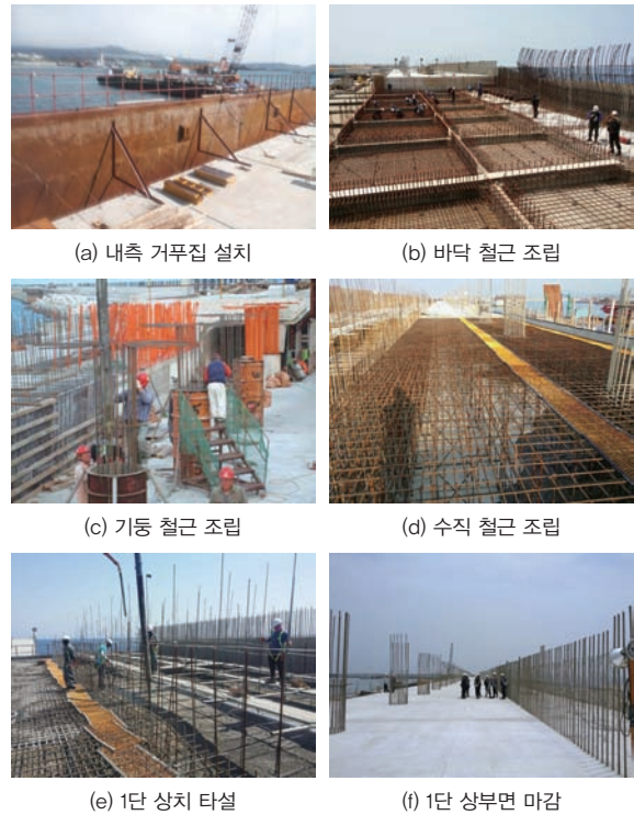
사진 6. 상치 1단 콘크리트 시공 과정
