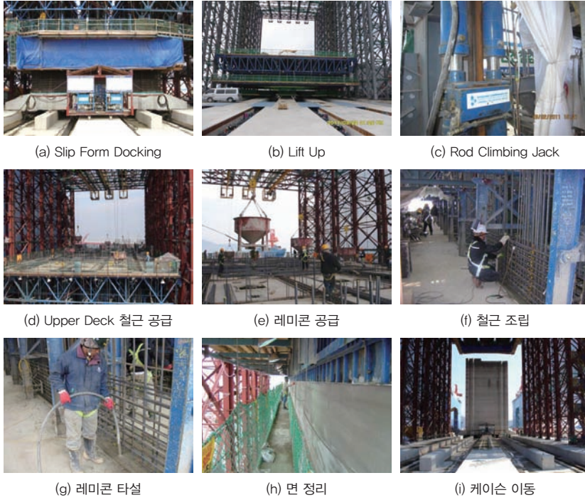
사진 3. Step 2의 케이슨 벽체 시공 과정
