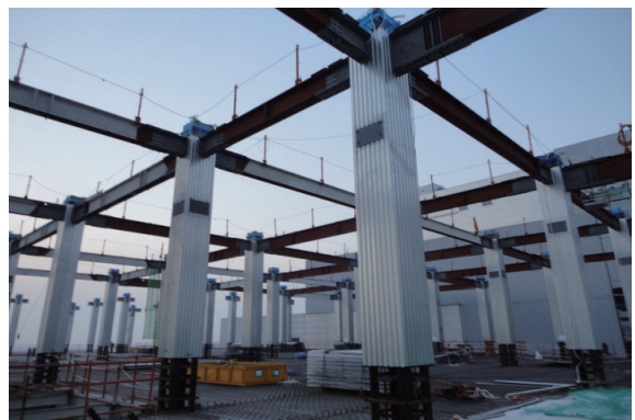
사진 1. Form-LPSRC 기둥 시공 모습
