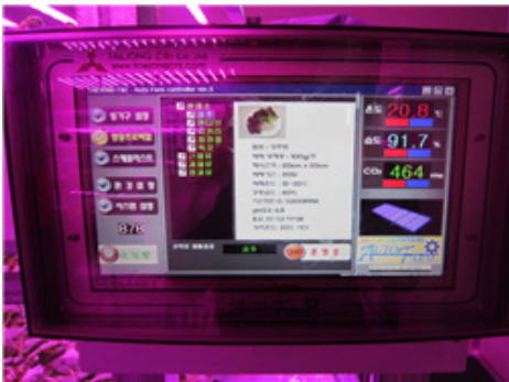
그림 6. 국내 식물공장 시설업체 시공 사진 (주)태중.
