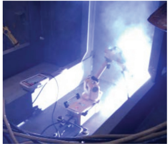
그림 14. 개발된 용접 로봇을 사용한 용접 작업.
