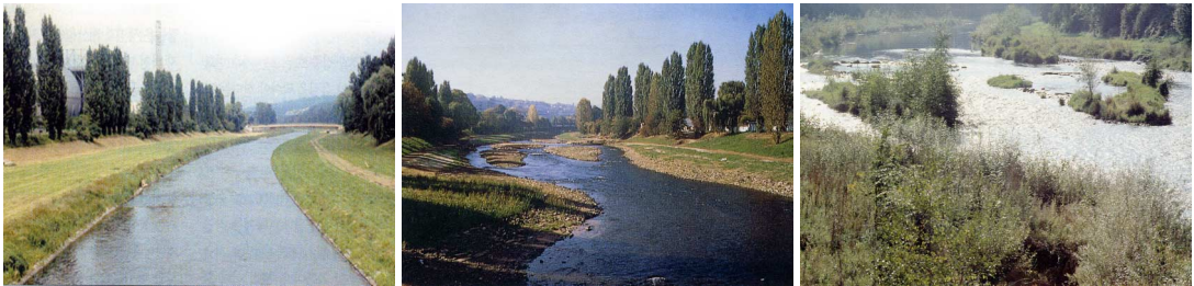
그림 1. 독일 엔즈(Enz)강의 복원공사 전) 공사직 후) 공사 2년 후 인공섬의 붕괴(LfU, 1995)
