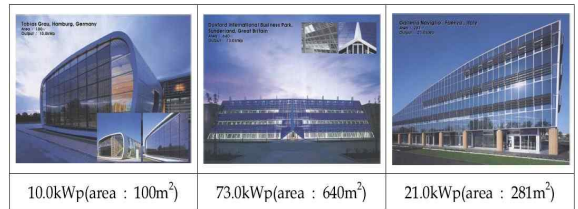
[태양광시스템이 건물과 잘 조화된 시공사례]
