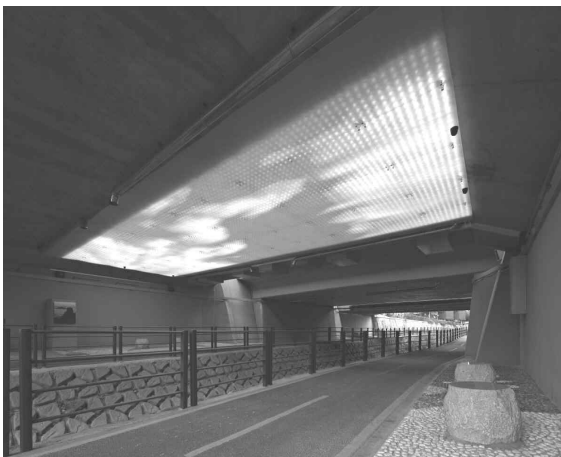
그림 3. 하늘/구름 연출 장면(시공 후)
