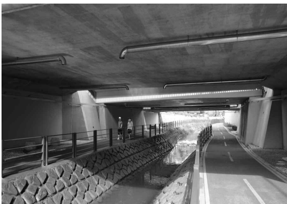
그림 1. 방학천 모래말본교 하부(시공 전)
