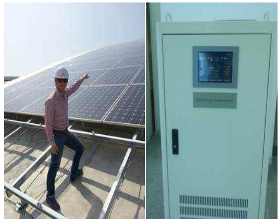
그림 7. 강릉 녹색 단지 내 5kW급 ESS(좌측 외부 태양광 모듈과 필자, 우측 ESS 캐비닛)
