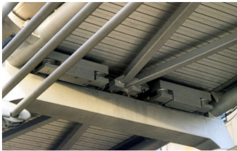
(b) 밀레니엄브리지 하부에 설치된 TMD(수직진동제어용) 그림 1 국내외 동조질량감쇠기 설치 사례
