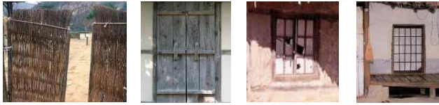
<그림 15> 사립문 <그림 16> 판장문 <그림 17> 용자살 <그림 18> 정자살
