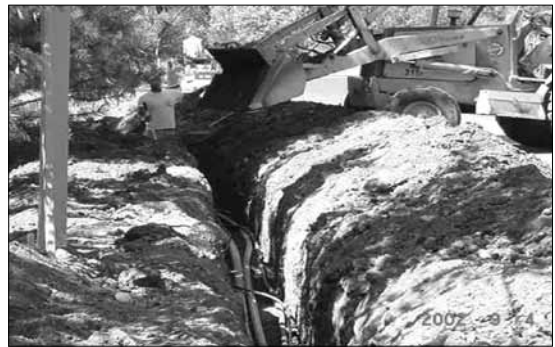
(b) 지중 케이블 설치 후 저회 채움
