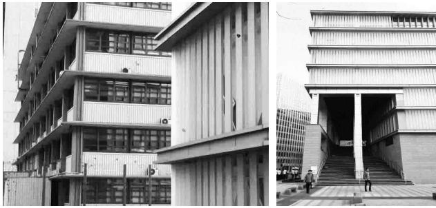
<그림 10> 대한민국역사박물관(우:변경후)와 주한미국대사관(좌:변경전)의 슬라브 디테일
