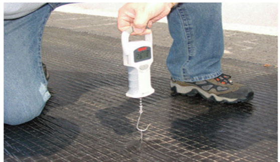
그림 6. 보강재 그리드 부착강도 현장 측정
