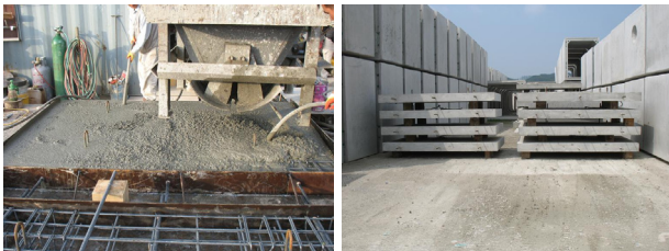
(e) 콘크리트 타설
