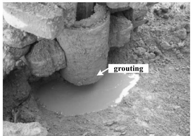
(d) Final grouting
