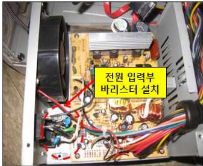
그림 6. 전원입력부에 설치된 바리스터 Fig. 6. Varistor installed on the power input section
