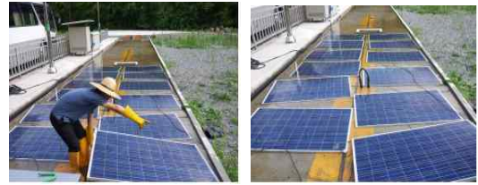
(a) 태양광 모듈 침수 상태
