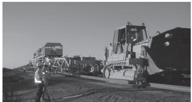
<그림 8> 대형장비에 의한 궤광부설 작업
