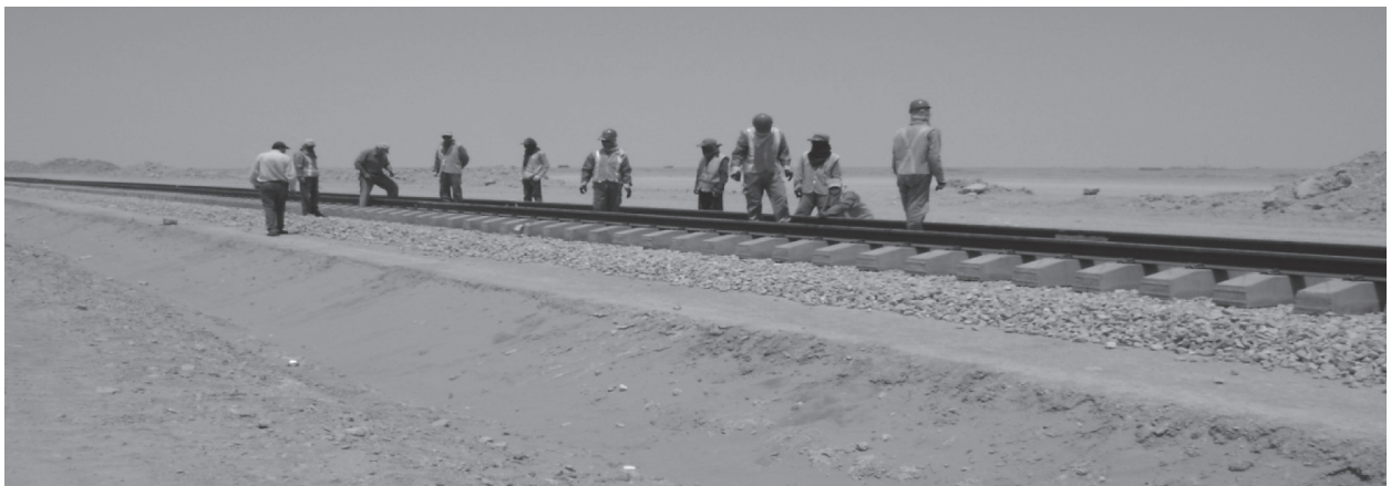
<그림 6> 인력에 의한 궤도부설 작업
