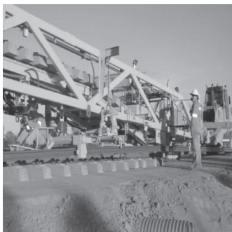
<그림 7> 대형장비에 의한 궤광부설 작업
