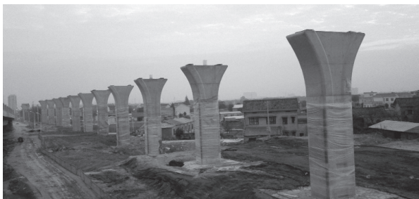
〈그림 8〉 창사 자기부상선로 교각 건설(2014년 12월)
