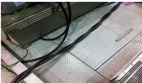
그림 4 컨버터 입력의 케이블 트위스트 Fig. 4 Cable twist of converter inputs
