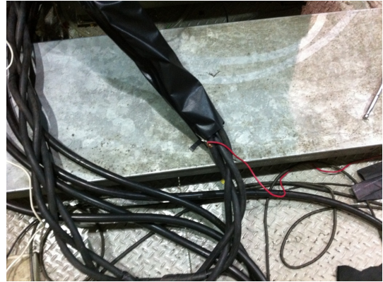
그림 13 인버터 출력의 케이블 차폐와 트위스트 Fig. 13 Cable shield and twist of inverter outputs
