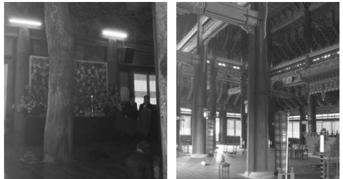
화엄사 각황전의 굵은 두리기둥(좌)과 경복궁 근정전의 수직 두리기둥.
