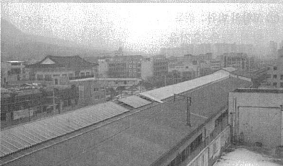
【그림 2】 망월사역 역사 지붕공사 현장 전경
