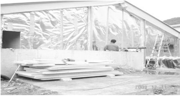
▲ 벽체부분 습기장벽 시공장면
