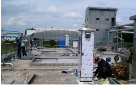
교반기 제어반 설치
