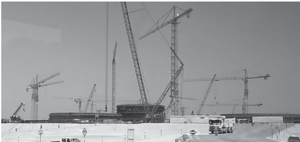
UAE 바라카 원전 건설 현장
