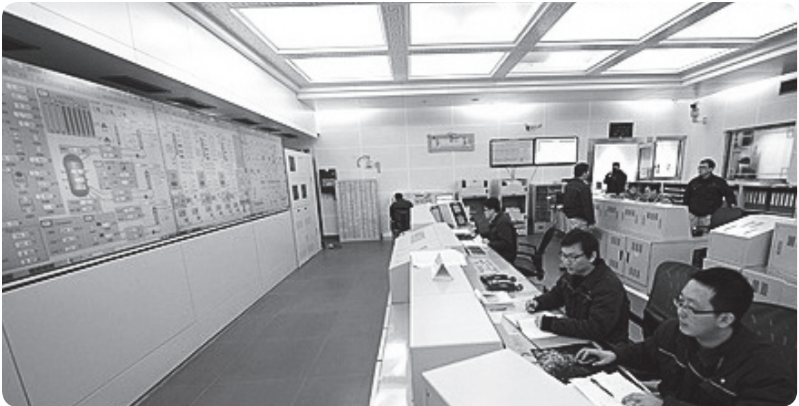
중국 동북지방의 첫 원전인 라오닝(遼寧)성 다롄(大連)시의 홍옌허(紅沿河) 원자력발전소 중앙제어실. (2013.2.) 현재 중국에서 건설되고 있는 원자로의 대부분은 CPR1000 모델로서, 이 모델은 지난 1970년대와 1980년대에 프랑스에서 도입한 제1세대 기압경수로(PWR)형 모델을 기반으로 하여 중국이 자체 개발한 것이다.
