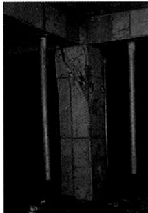
[그림 1] 부상방지대책 미흡에 의한 사고(기둥 및 바닥 균열)
