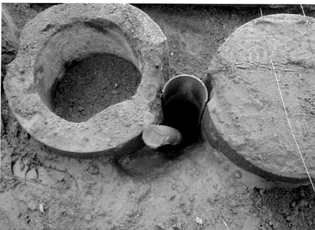
[사진 5] 그라우팅 시공
