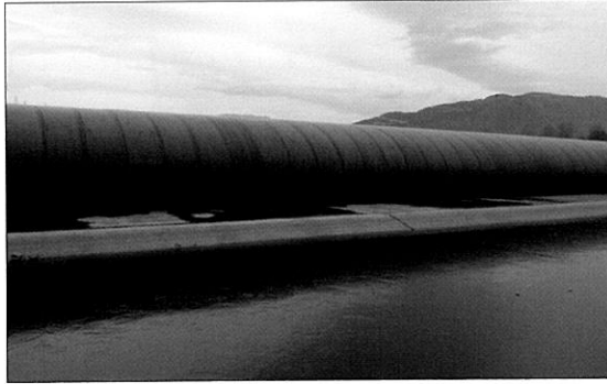
〈그림 5〉 Yongding강에 설치된 다양한 러버보의 형태
