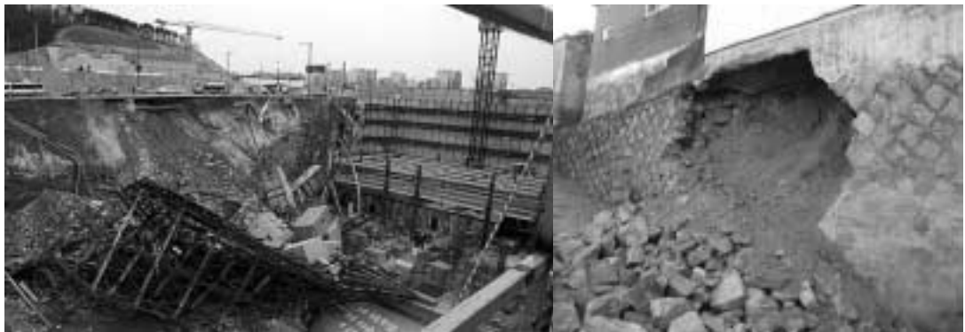
그림2. 해빙기 공사장 붕괴(左) 및 석축 붕괴(右) 사진(출처, 연합뉴스 & 서울시)
