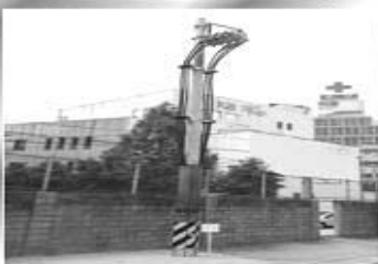
선로 구분 및 개폐를 위한 개폐기를 전주위에 설치
