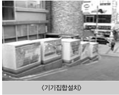
[그림 3] 지중화용 지상기기 설치 전경
