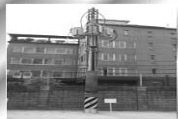
저압선로 전력공급용 변압기를 전주 위에 설치
