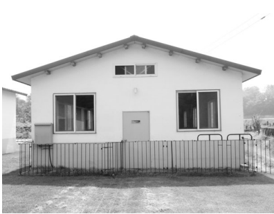
▲ 단열재 시공전의 축사
