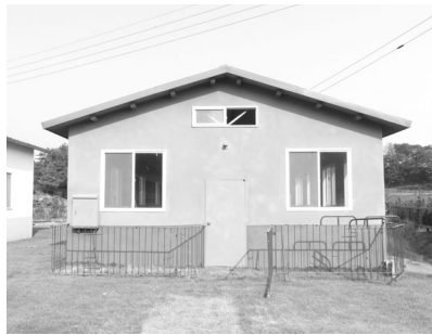
▲ 단열재 시공후의 축사
