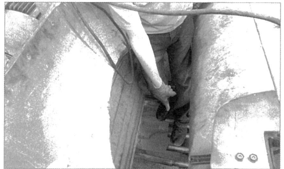
【그림 8】 피재자의 작업 위치(진동스크린의 철판 용접 작업중)
