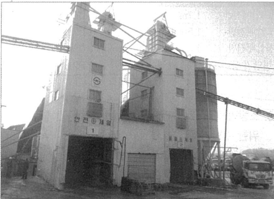
【그림 1】 배처플랜트 전경(사고지점은 1호기 뒤 진동스크린 부분임)
