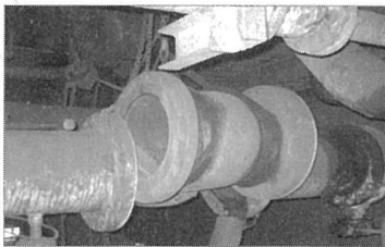
【그림 1】 배관라인 밸브조립 작업
