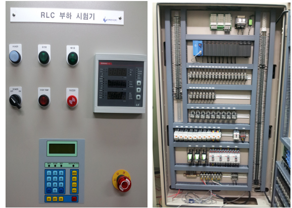
그림 4 임피던스 부하조정기 Fig. 4 Impedance Load Controller
