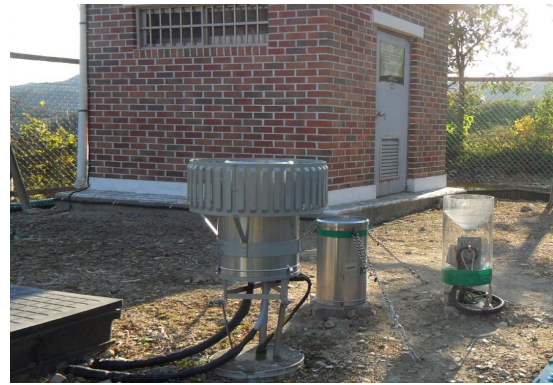
그림 7. 부귀우량국에 설치된 강수량계 Fig. 7 Precipitation Gauge Installed in Bugwi Precipitation Station
