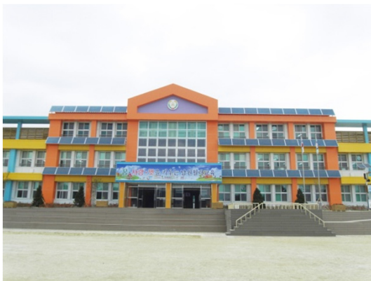
그림 1. 신재생에너지(BIPV) 설치
