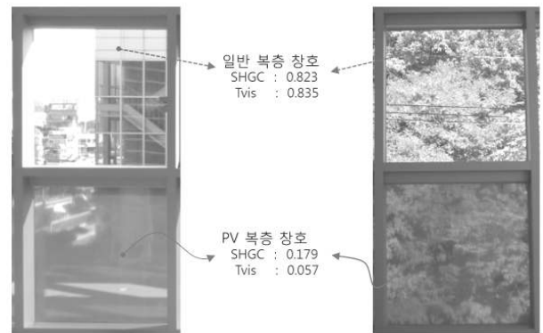
그림 5. 일반 복층 창호와 BIPV 복층 창호(좌:남측면, 우:동측면)
