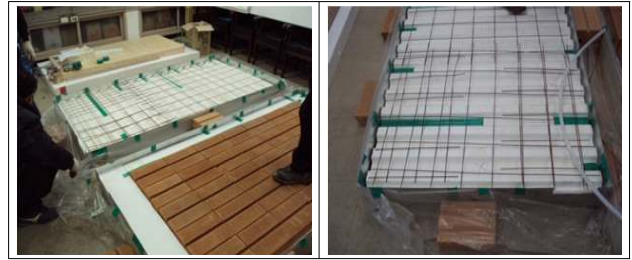
항토바닥재 및 굴곡 스티렌폼 바닥재 타설
