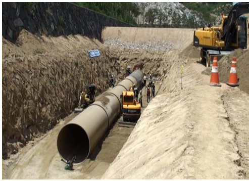
(d) Backfill
