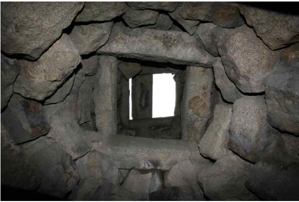
그림 4. 첨성대의 내부에서 바라본 통로의 모습. 19 ~ 20층, 25 ~ 26층에 길다란 정자형 장대석이 걸쳐 있는 모습이 보인다(자료 국립문화재연구소, 2009년).
