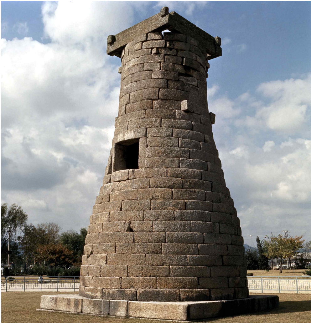
그림 1. 경주시 인왕동에 신라 선덕여왕(재위 632 ~ 647년) 때에 축조된 화강석 석조물. 현존하는 가장 오래된 천문대다. 높이 9.17 m, 윗지름 2.5 m, 밑지름 5.17 m, 지대석(地臺石) 1변의 길이 5.35 m이다. 기단(基壇)은 사각형 두 단으로 일단 8석, 이단 12석으로 되어 있고, 그 위에 석재(石材) 365개가 사용된 27단의 층단부가 있다. 국보 제31호(문화재청 자료 참고).
