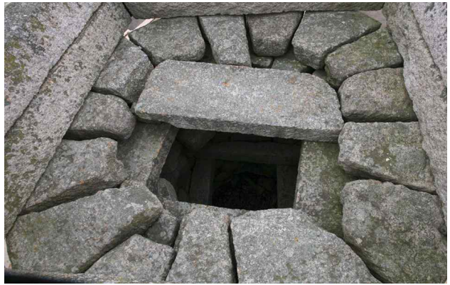
그림 5. 첨성대 상단의 모습. 판석 밑에는 판석을 받치는 정자형 장대석이 보인다(자료 국립문화재연구소, 2009년).
