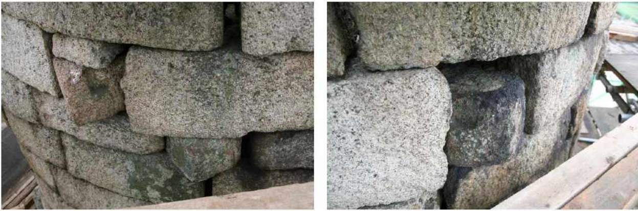
그림 7. 26단 장대석 북동쪽 돌출부위에 끼어있는 보조석(좌)과 북서쪽 장대석 돌출부에는 □ 형 음각부분이 보이고 보조석은 실제로 “一處欠”으로 되어 있다(자료 국립문화재연구소, 2009년).
