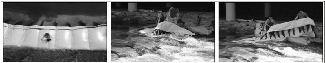
그림 12. Pocket Dam 해체 과정
