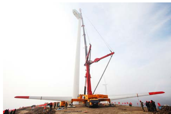
그림 2. 대형 풍력 시스템 건설 현장
