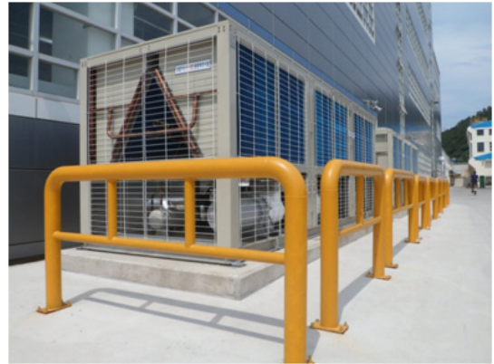
Fig. 5 도장 플랜트 냉수 제조 시스템
