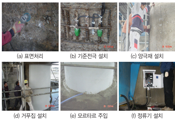
사진 1. 외부 전원법에 의한 전기방식의 시공 순서
