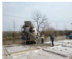
(e) 콘크리트 타설
