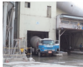
(c) 콘크리트 생산
