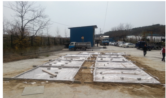
사진 2. 모의 슬래브 부재의 설치전경
