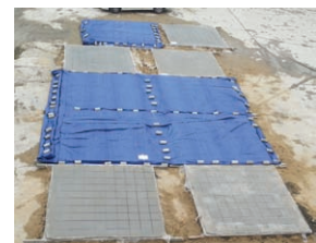
(h) 콘크리트 양생
