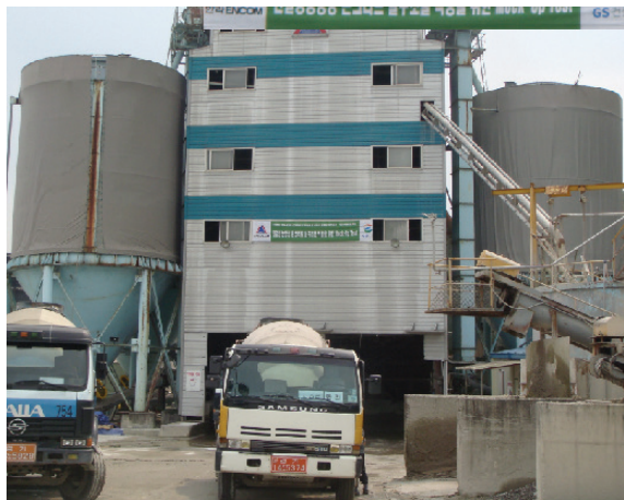
사진 4. 단열성능향상 콘크리트의 생산실험
