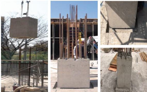
사진 4. 프리캐스트 고인성 섬유복합체 박스 설치
