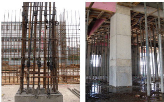
사진 5. 상부 철근 연결 및 후타설 콘크리트 완성
