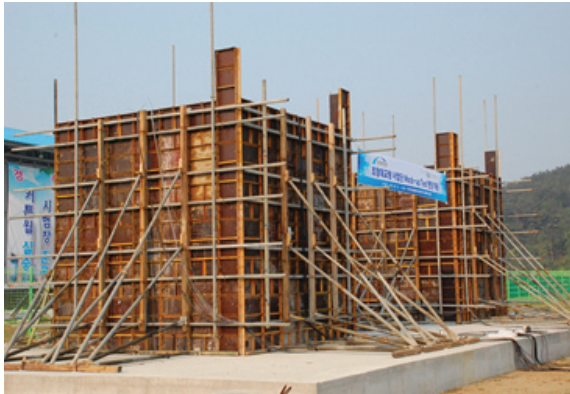
사진 1. 4m×4m×4m Mock-up Test 전경
