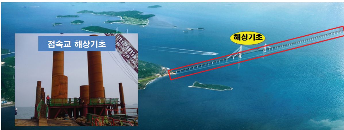
그림 8. 수중불분리 콘크리트 적용 구간(새천년대교 현장)
