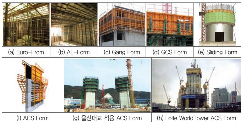
그림 1. 철근콘크리트(RC)조 거푸집의 종류
